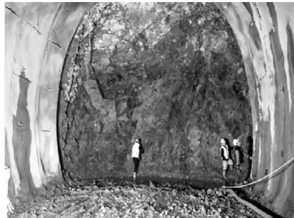
경주 방폐장 공사현장의 모습 지하수가 콘크리트를 뚫고 동굴 내부로 들어오고 있다. 이 지하수를 모아서 오른쪽 아래에 보이는 관을 통하여 밖으로 퍼내고 있다. 암반이 불안하고 지하수가 특별히 많은 곳에 방폐장을 선택한 것이 위험성의 근본적인 이유이다.
