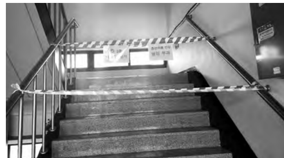
공사 전 (충주 중원중학교 옥상 진입 계단)
