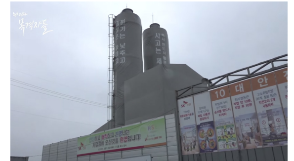
건설허가도 나기전 진행 중인 신고리 5·6호기 수중취배수구조물 축조공사
