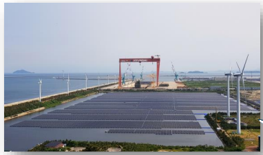
군산 유수지 18.7 MW (2018.06) 국내 최대 규모수상 태양광 발전소
