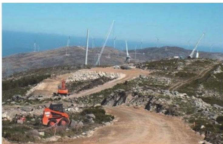
포르투갈 Alto Minho 풍력발전 공사현장
