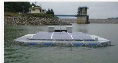
전남 주암 다목적댐 2.4 kW (2009) 국내최초수상 태양광 실증 플랜트 사업
