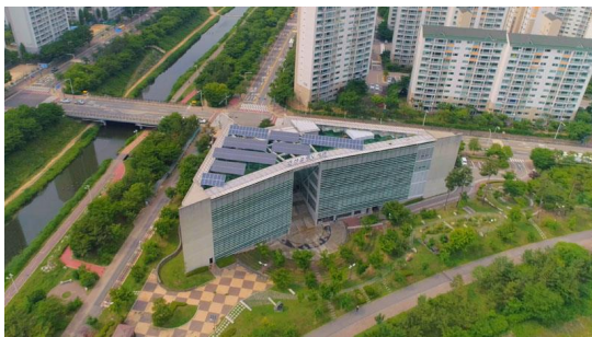
안산시민발전협동조합 햇빛 1호발전소
