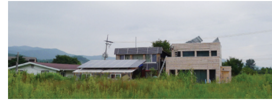
경기도 양평 회현리에 지어진 에너지독립하우스 1호와 2호. 왼쪽이 1호, 그 옆에 있는 낮은 건물은 에너지 발전 시스템이 설치된 두 집의 운실이다.
