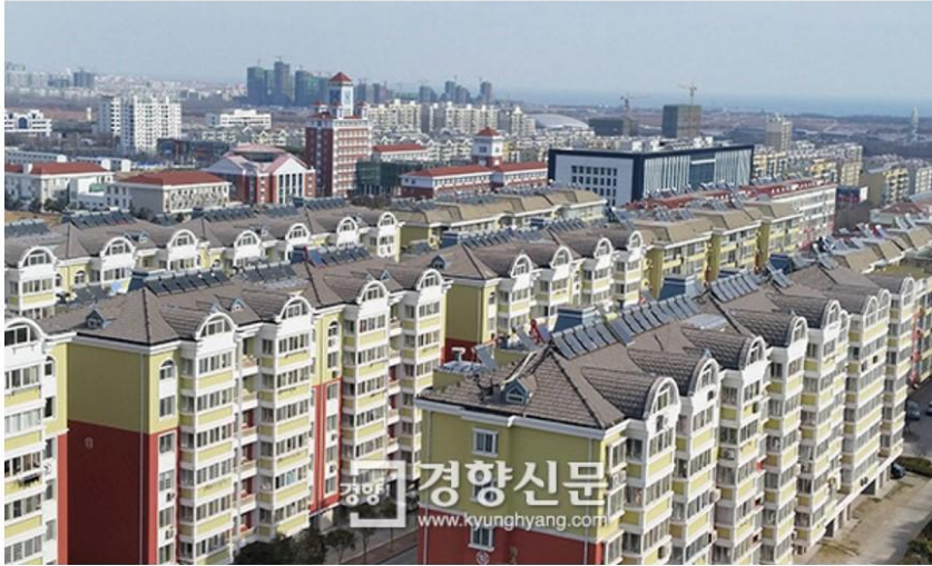
태양광 집열판이 설치된 중국 르자오시 아파트 출처: 경향신문
